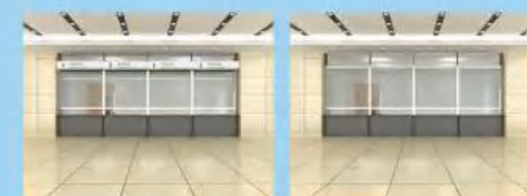
安装主台面 Countertop installation
